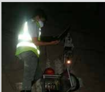
地铁隧道施工期多机联测
