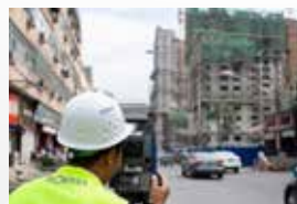
施工竣工测量
